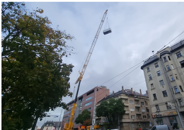
3. kép. Hőszivattyú-daruzás
